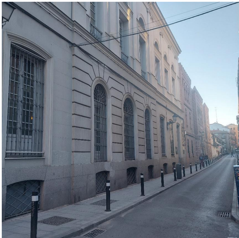
BIBLIOTECA MARQUÉS DE VALDECILLA. CALLE NOVICIADO
